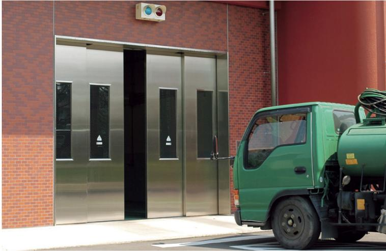
「青信号」で進入する車両を床に埋設したループコイルスイッチが検出し、ドアが開きます。車両が内部に入って投入を終えて出口側に進むと、センサーが検出し自動ドアが開き、退出します。内部に車両が満車の場合、外部信号は「赤」が点灯し進入を制限します。また、空気の流出を防ぐために、入り口側と出口側自動ドアはインターロックされて同時に開くことのないようになっています。
