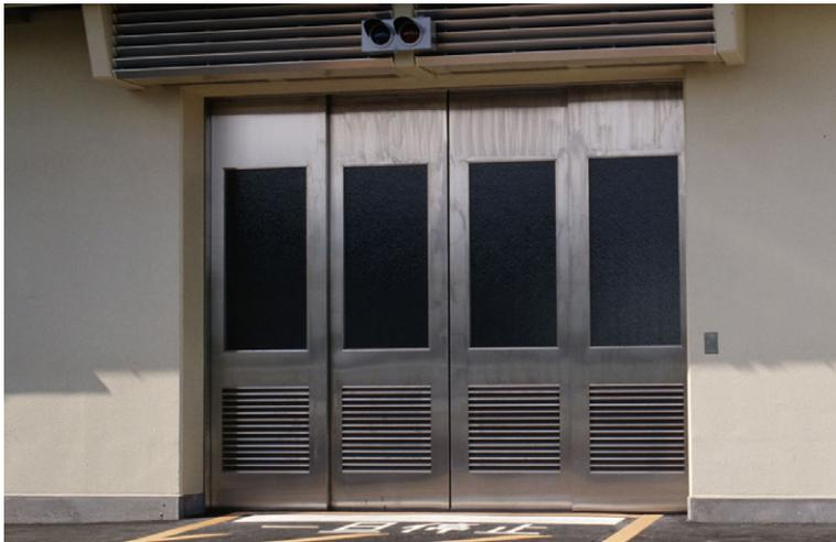
ごみ投入口に、大型扉仕様の2枚折り戸・両開き方式が採用され、寺岡の純電気式大型扉用スイングエンジンを使用しております。
