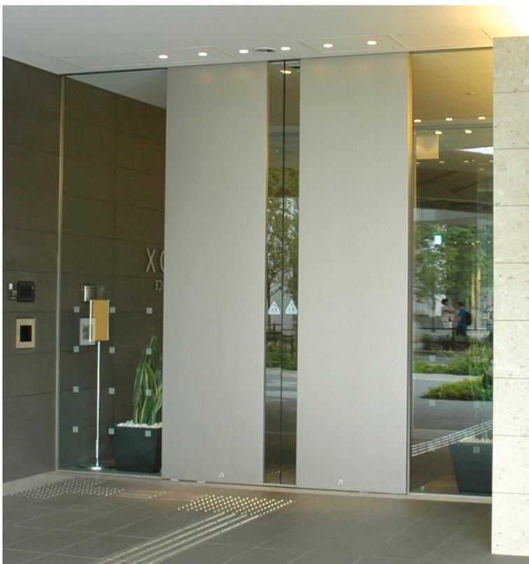
自動ドアと電気錠は、専用コントローラによって連動し、確実
