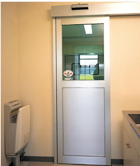
衛生管理区域への出入りに設置し、手を触れず開閉する自動ドアと、二
